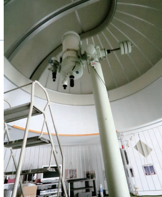
屋上にある天体観測ドーム。地域の小学生を対象とした観測会も行っている。
