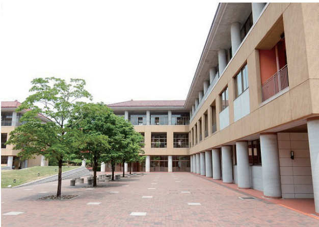
2001年に竣工した中学新校舎。昨年4月には「総合体育館2014」も完成し、学内がいっそう活気づいている！
